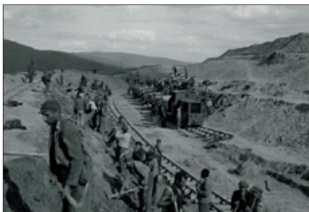
Výstavba železničnej trate Hanušovce n. Topľou – Strážske, 1942
